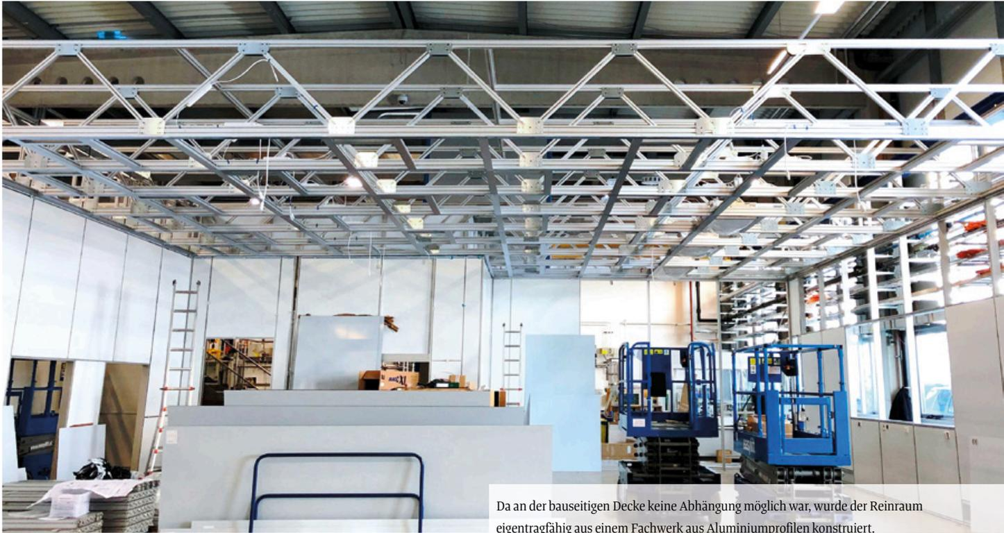
Da an der bauseitigen Decke keine Abhängung möglich war, wurde der Reinraum eigentragfähig aus einem Fachwerk aus Aluminiumprofilen konstruiert.
