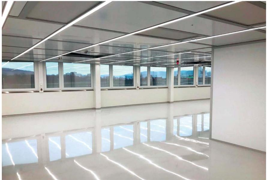
Der Reinraum kurz vor der Fertigstellung: Die Fenster des Bestandsbaus wurden abgedichtet und in den Reinraum integriert, um Platz zu gewinnen.
