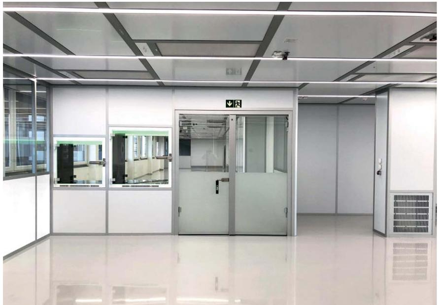
Über mehrere farblich visualisierte Materialschleusen werden die Implantate sicher von der Reinraumzone ISO7 in die Reinraumzone ISO 8 transportiert.
